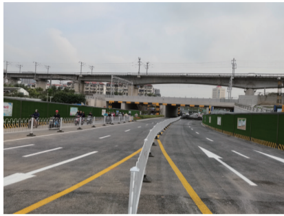
局部路幅恢复通车。 通讯员供图
