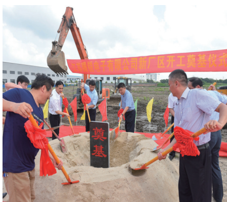
腾锐电子项目开工
