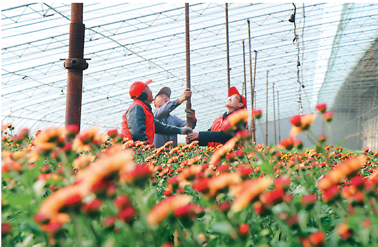
28日，在寒潮即将来临之际，东海县双店镇组织网格员走进鲜花大棚，帮助花农加固钢筋支架，防止积雪压塌大棚。 宋彦伟摄 视觉江苏网供图
