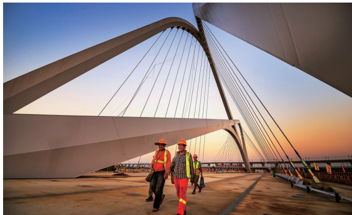
南部新城承天大道跨秦淮河大桥
