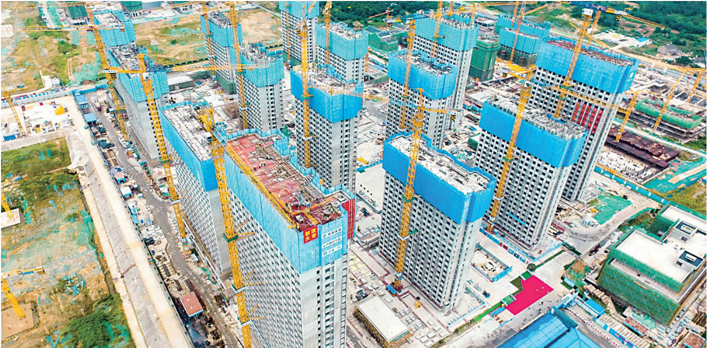
14日,伴随着屋面板最后一车混凝土浇筑完成,由中建二局承建的南京绿洲机械厂东侧地块保障房项目E地块的1栋和13栋楼主体结构封顶。该项目位于板桥新城,总建筑面积28.18万平方米。 本报记者 范俊彦 摄
