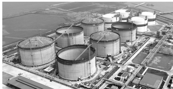
9月7日,盐城滨海港工业园区,俯瞰液化天然气储罐升顶作业现场 李根 徐斌 摄 视觉江苏网供图
