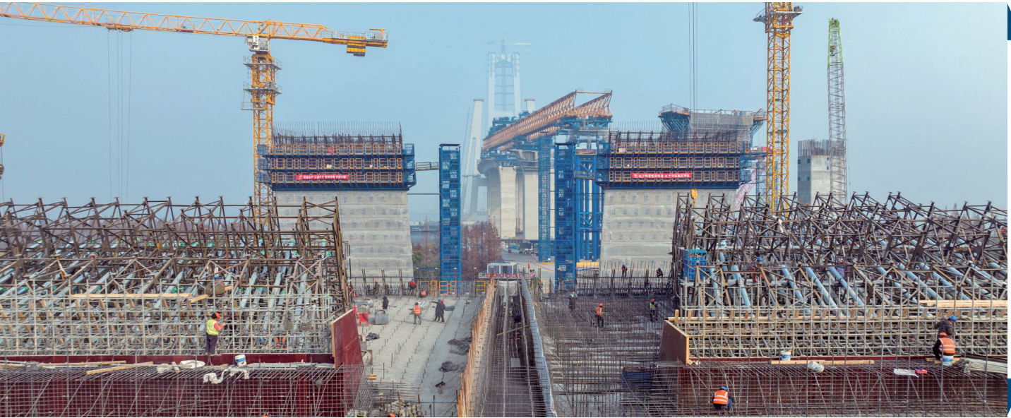
12月17日,张靖皋长江大桥南航道桥南锚碇施工正在抓紧推进中。目前,南航道桥南锚碇正在进行锚块和散索鞍支墩施工。据悉,南锚碇基础长110.05米、宽75.05米、深83米,是悬索桥“扎稳马步”的“大秤砣”,承载着上部结构14万吨的锚固力,建成后将成为世界最大的地连墙锚碇基础。 陈佳琪 摄
