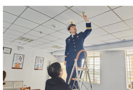
近日，盐城市建湖县消防救援大队开展消防隐患排查“回头看”工作，对前期排查出的火灾隐患逐一核查，逐项评估整改效果，实现隐患整改闭环管理。 朱扣红 摄
