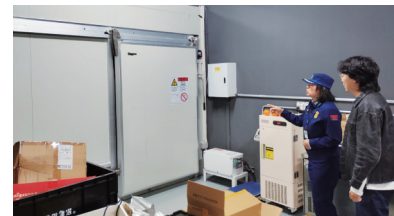
连日来,无锡经济开发区消防救援大队持续开展冷库建筑保温材料专项“回头看”行动,针对前期排查发现的问题,采取“清单式”复查、“销号式”管理,确保整改措施落实到位。黄梦雪摄
