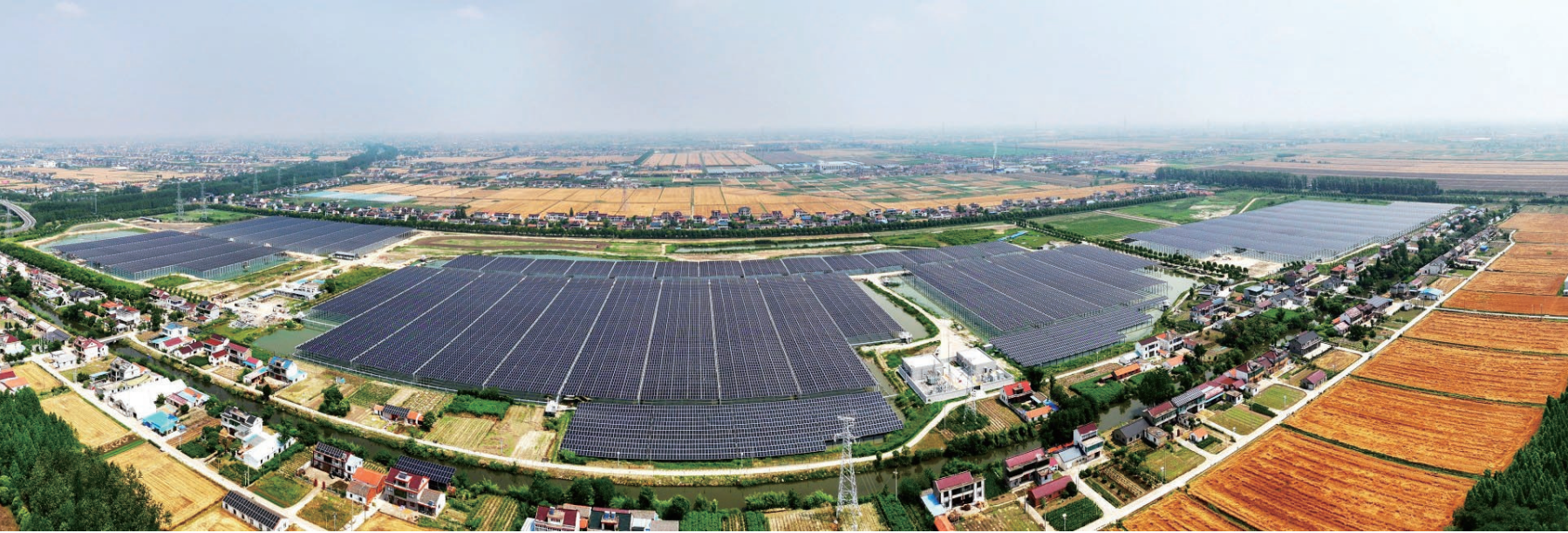
6月2日,海安市大公镇群益村70兆瓦渔光一体产业园施工加快,成片光伏板沿塘铺设,与田园村落相映生辉。近年来,海安市依托本地水域资源,深耕渔光互补产业,水上光伏发电、水下生态养殖,盘活闲置水面资源,拓宽村集体增收路径。 顾华夏 摄
