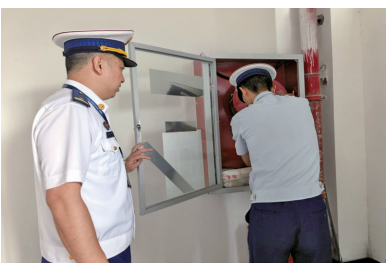
近日，响水县消防救援局深入辖区重点单位开展“双随机、一公开”消防安全检查。 马福蛟 摄
