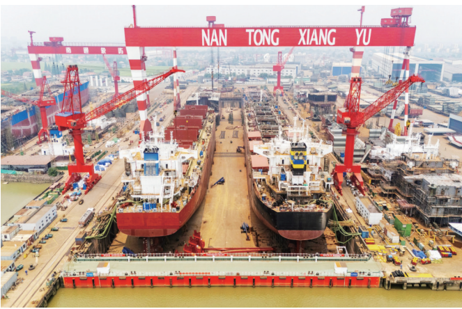
6月28日,南通市通州区,南通象屿海洋装备股份有限公司厂区内,多艘在建船舶同步施工建造。临近年中,企业开足马力赶制海内外订单,全力冲刺“半年红”。 霍慧勇 摄
