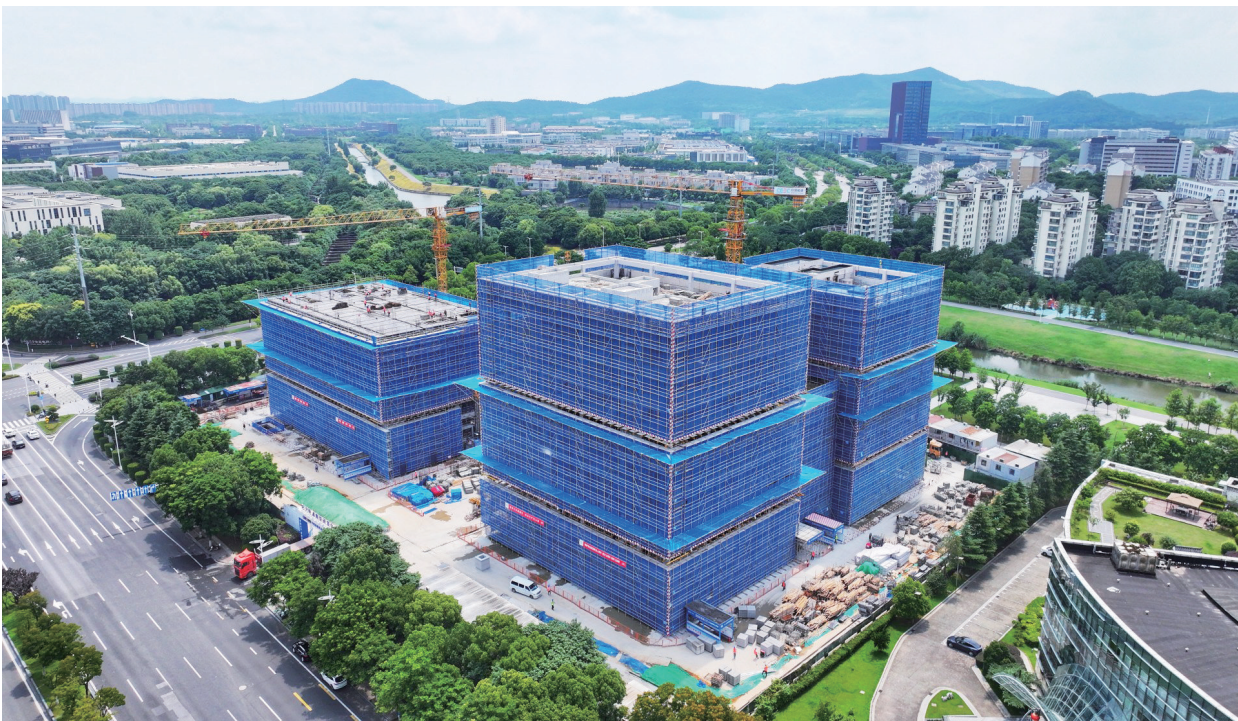
7月2日,航拍省级重大项目阳光电源南京研发中心施工现场,项目建设正全速推进。该项目总建筑面积约86268.49平方米,布局科研研发、综合服务配套两大功能板块,集新能源技术攻坚、试验验证、成果转化、人才办公、产业交流于一体。目前园区首栋建筑已完成主体结构封顶。
