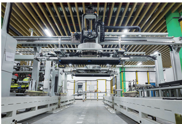
6月30日,位于宿迁经开区的江苏国峰元储新能源科技有限公司首台批全自主研发20兆瓦5MWWh AI储能直流舱顺利下线、正式投产交付。
