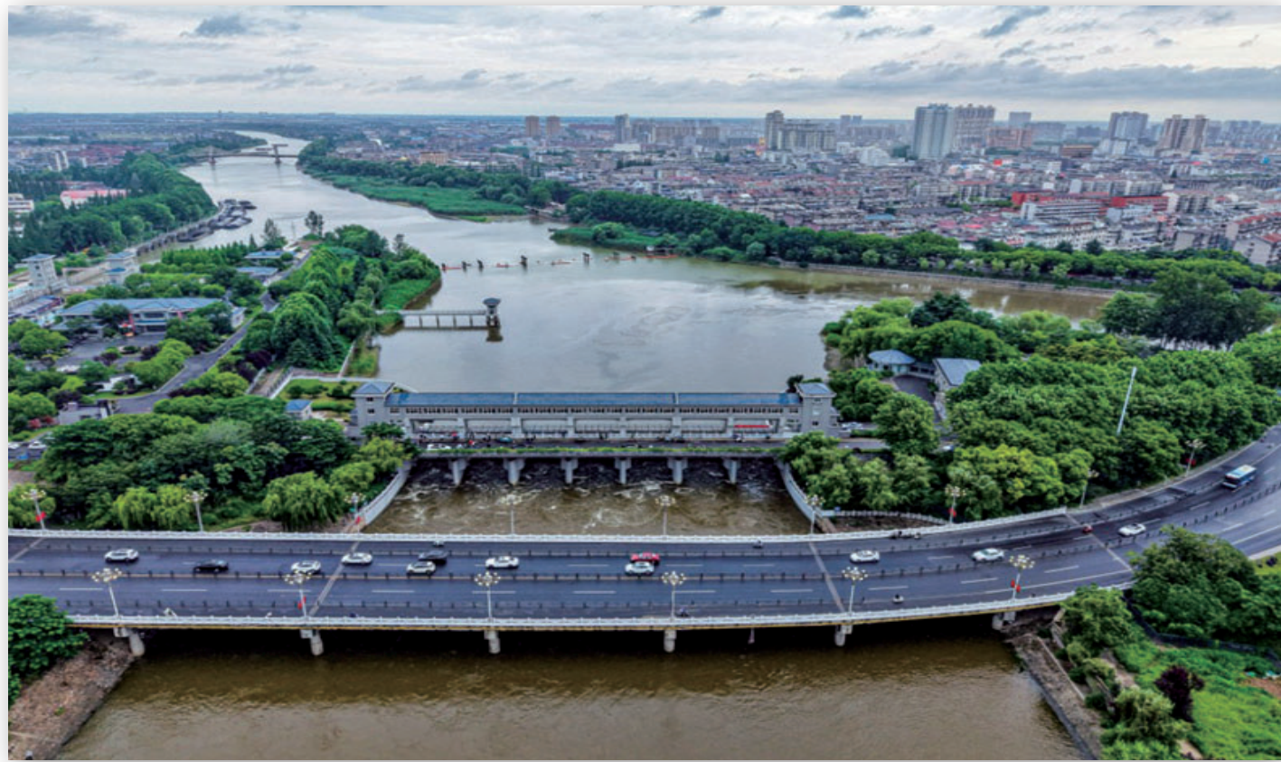
近日，江淮地区连续降雨导致水位上涨。根据江苏省水旱灾害防御调度指挥中心指令，江都水利枢纽芒稻闸于7月3日11时向芒稻河开闸放水流入长江，江都水利枢纽万福闸于7月4日9时30分向廖家沟开闸放水流入长江，图为7月5日，芒稻闸开闸放水。
