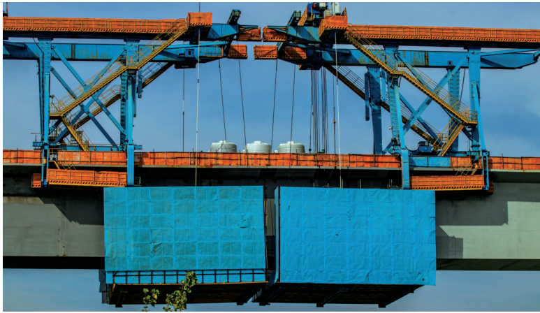
7月7日,沪渝蓉(北沿江)高铁通州段最后一个关键节点——跨沈海高速及通吕运河的南通特大桥在蓝天下格外雄伟。7月6日,该节点合龙,标志着上海、南京、合肥三大都市圈间快速新通道即将建成。 钱伟章 摄
