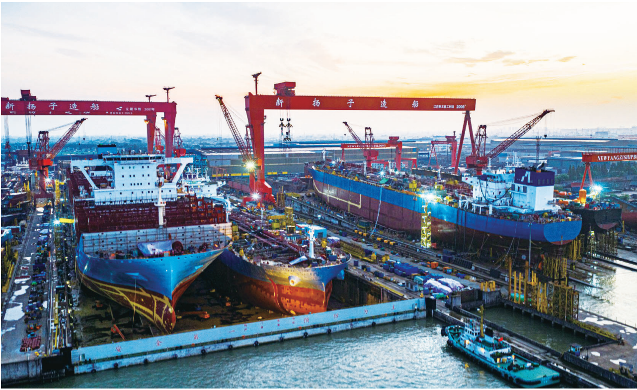
7月25日,江苏新扬子造船有限公司,多艘船舶开工建造中。今年上半年,江苏口岸累计出口新造船船280余艘,同比增长34.6%。一大批绿色化、高端化、智能化的“江苏造”船舶海工装备扬帆出海,持续领跑全球航运市场。 计海新 摄
