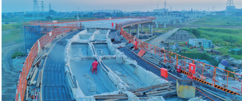
8月2日清晨,海太长江隧道北接线336高架互通施工现场机器轰鸣。高温之下,一线建设者坚守岗位,抢抓施工黄金时段,奋力推进重大交通工程建设。 宋武斌 摄(视觉江苏网供图)
