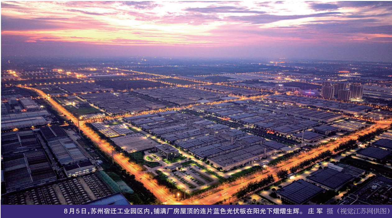
8月5日,苏州宿迁工业园区内,铺满厂房屋顶的连片蓝色光伏板在阳光下熠熠生辉。 庄 军 摄(视觉江苏网供图)
