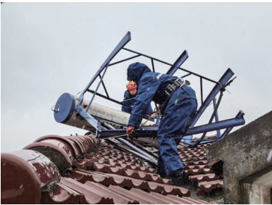
8月10日,台风“白海豚”影响宜兴,强风导致部分户外太阳能设备松动,存在坠落风险。丁蜀消防专职队迅速赶赴现场,消防队员冒雨开展加固作业,及时消除高空坠落隐患。
