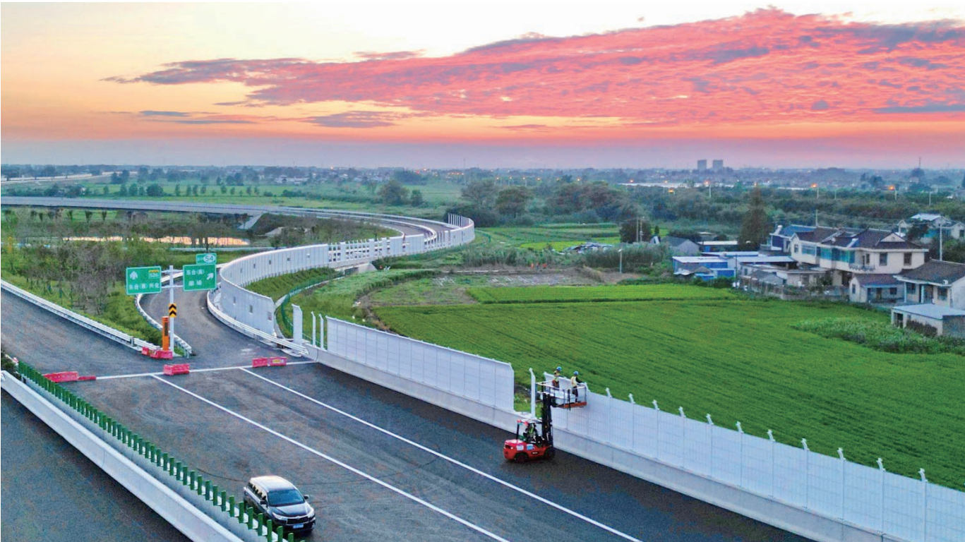
8月15日,风停雨止,中铁四局建设者抢抓有利天气,在东兴高速东台互通段紧张进行声屏障安装作业。东兴高速串联东台、兴化两地,是江苏省高速路网重要横向联络线,主体工程已近完工,预计今年10月通车。
