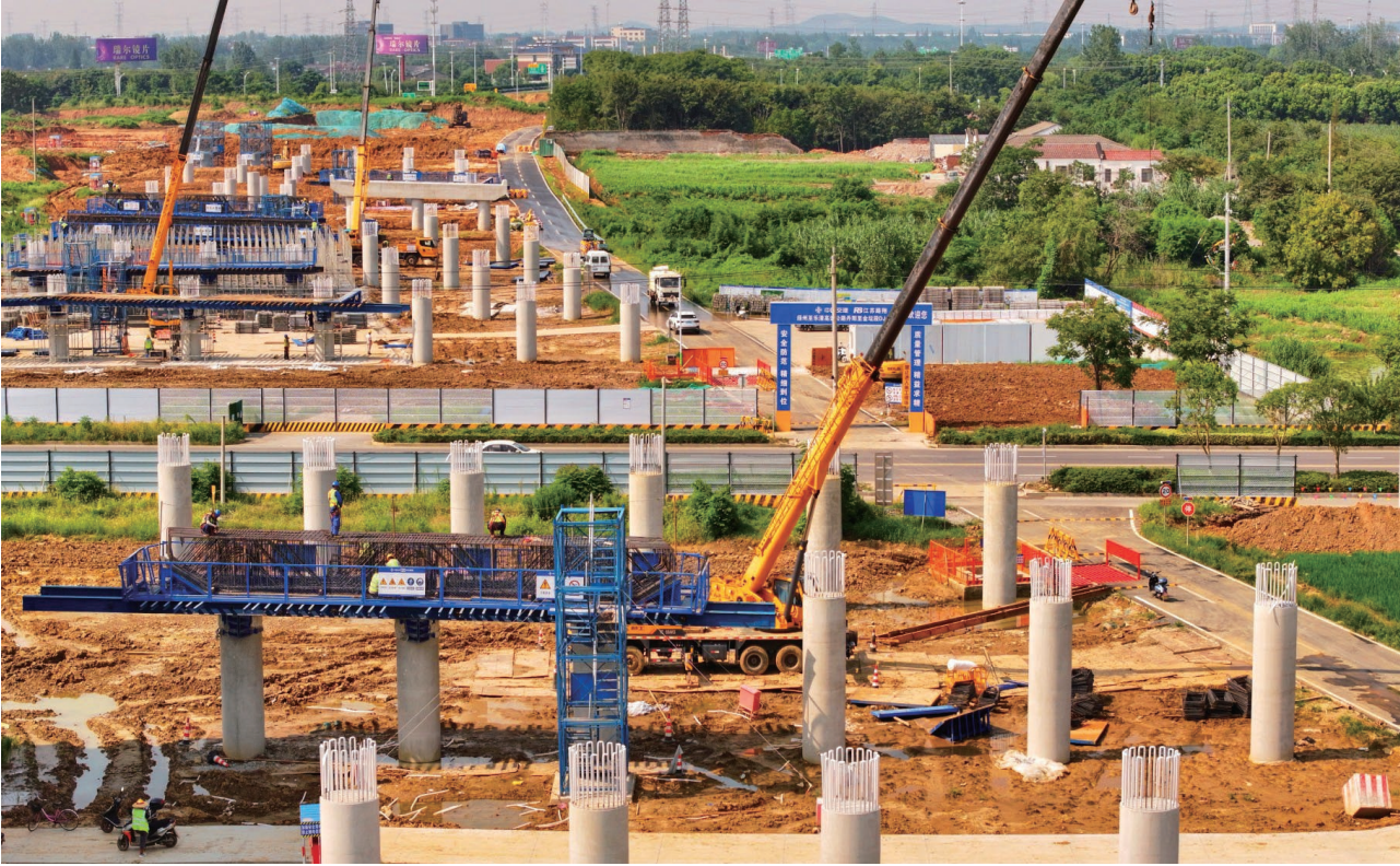
由中交三航局承建的省级重大交通工程丹金高速项目DJ-DY1标段目前正抢抓工期,有序推进钻孔灌注桩、水泥土搅拌桩、系梁、墩柱及路基等主体施工,桩基施工已完成超八成。项目建成后,将打造省内领先、区域一流的跨市域快速交通廊道。赵亚玲 摄(视觉江苏网供图)
