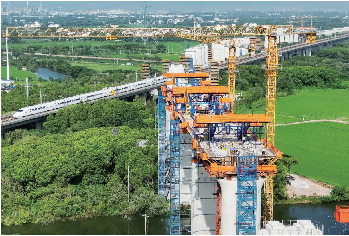
8月26日,无锡市惠山区洛社镇盐宜高铁施工现场,建设者正加紧施工作业。该项目是国家“八纵八横”高铁网及江苏“六纵六横”骨干线路的重要组成部分,建成后 will 补强沿海高铁通道,助力长三角一体化发展与江苏南北跨江融合。 潘正光 摄(视觉江苏网供图)
