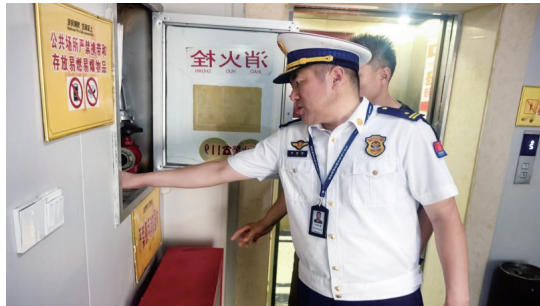
近日,响水县消防救援局行政执法人员赴辖区五洲宾馆开展“双随机、一公开”消防安全检查。
