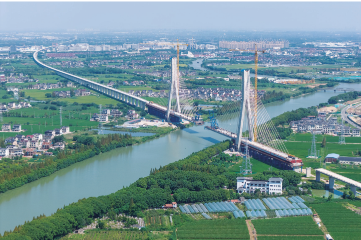
9月13日,通苏嘉甬高铁常熟段抢抓金秋有利窗口期,各项施工作业有序推进。 孔繁立 摄(视觉江苏网供图)
