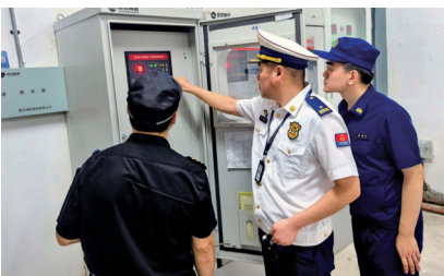
近日，响水县消防救援局行政执法人员分组深入辖区东城壹号小区、彩鑫酒店、伟亚钢结构、家常菜馆等五类重点领域单位场所，开展消防安全集中夜查行动。 肖 马 摄
