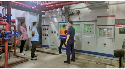
为进一步压实消防安全责任，排查整治各类消防安全隐患，筑牢辖区安全生产和消防安全防线，近日，无锡市梁溪区消防救援局监管局深入辖区重点单位，开展消防安全专项检查工作，并提醒相关单位做好日常消防演练等工作，护航辖区安全稳定。 张 洁 陈鹏 摄
