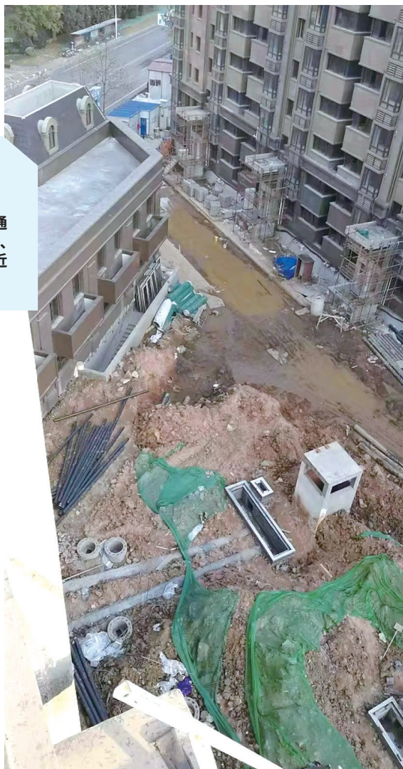
通宇林景尊园工地现场实拍。
