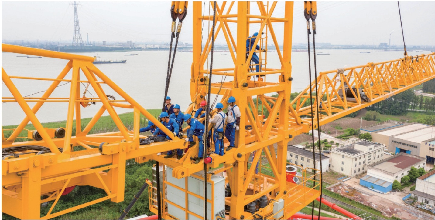
7月16日,在输电铁塔500千伏凤城至梅里长江大跨越北塔施工现场,江苏省送变电有限公司施工人员顶着高温组装铁塔吊装起重臂。该设备最大起重半径为50米,可以起吊30吨重量。 史俊 摄 (视觉江苏网供图)
