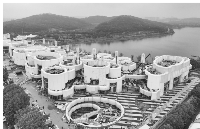
2026年3月18日,南京,航拍建设中的仙林德基奥莱。纯白色的弧形立面如起伏云朵,与传统商场的冷硬玻璃截然不同,视觉冲击力十足。该项目外立面已基本完工,建设者正加紧进行作业。空中连廊在2、3层将大部分商业体无缝衔接。据悉,这座“云境乌托邦”将于今年6月亮相,为南京带来兼具潮流与性价比的全新消费地标。 邵丹 摄 视觉江苏网供图
