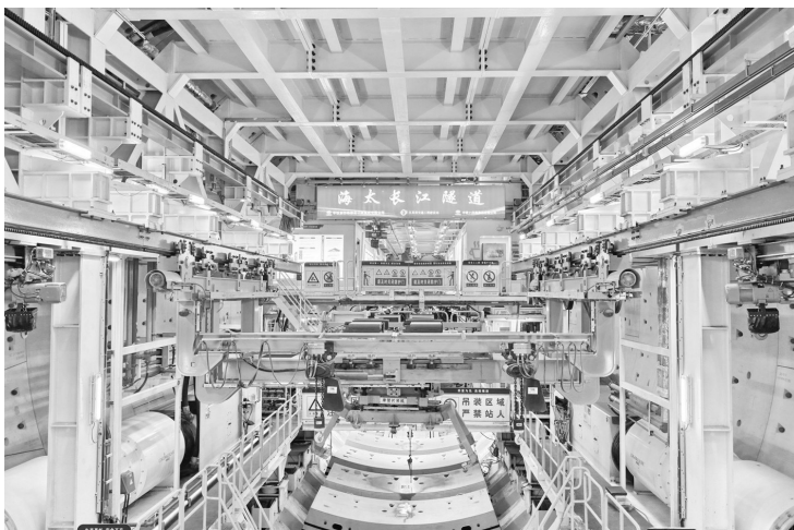
海太长江隧道“江海号”盾构机掘进达4658米 许丛军 摄
