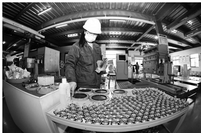
3月24日,在海安市国家级专精特新“小巨人”企业江苏恒炫电气有限公司车间里,工人们在赶制应用在智能电网等项目上的充气柜、高低压成套开关设备等产品。 顾华夏 摄 视觉江苏网供图
