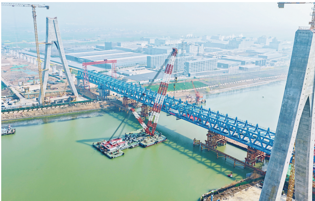
3月25日,潍宿高铁跨京杭运河特大桥主桥顺利合龙 张堃 摄 视觉江苏网供图
