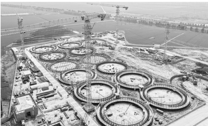
3月25日,宿迁市泗洪县归仁镇境内的国家粮食储备库建设工地,一片繁忙,施工方全面推进工程建设,保障工程进度。
