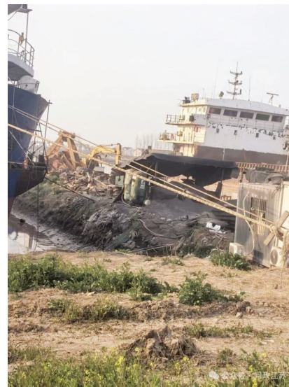
恒兴船业维修部现场
