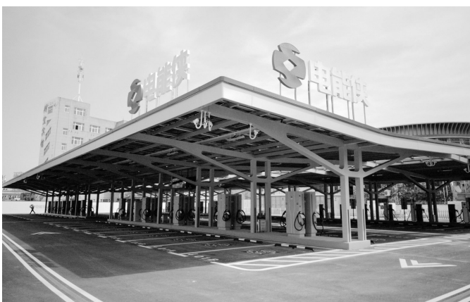
4月6日,徐州市区最大的新能源充电站建设完工,即将投入运营。 安炳力 摄 视觉江苏网供图
