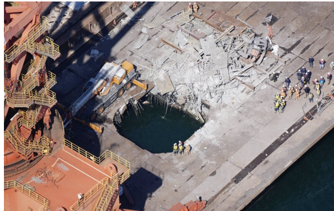
巨型配重将钢板砸了一个大窟窿 图源日媒
