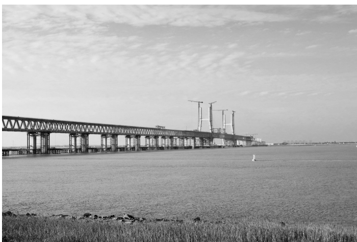
建设中的崇启公铁长江大桥 通讯员提供
