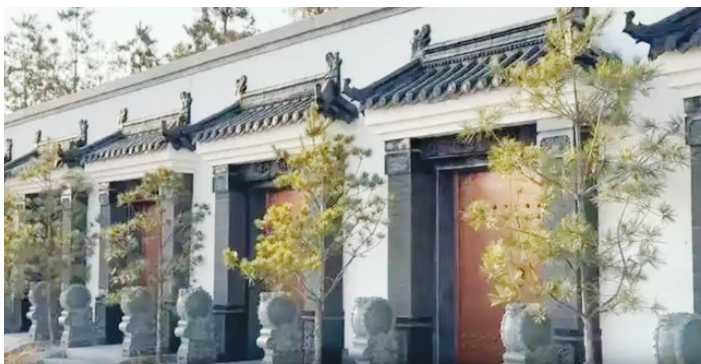
长庚生态园“锦绣苑”北侧已建成的35座超标豪华“住宅式”墓地
