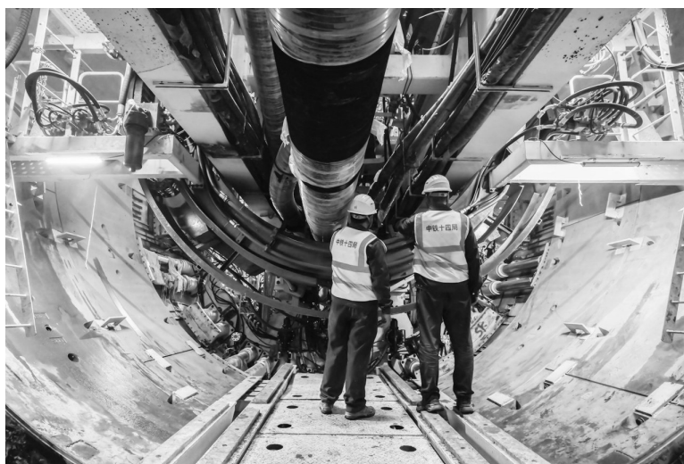
盾构机施工现场 林凤 邵丹 摄
