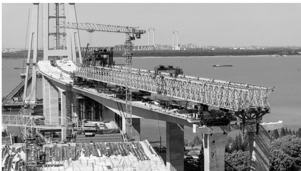
5月9日,由中交二航局承建的张靖皋长江大桥南引桥右幅成功合龙,成为全桥首个完成合龙的引桥,为后续架梁等施工奠定了坚实基础。据悉,南引桥均采用节段预制悬臂拼装工法进行施工,南引桥共 340 榀预制箱梁,目前已经安装 244 榀,预计今年 9 月份全部架设完成。陈佳琪 摄 视觉江苏网供图
