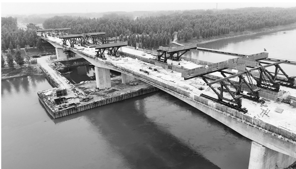
6月2日,连宿高速公路新沂河特大桥南岸主桥施工现场。近日,连宿高速公路新沂河特大桥南岸主桥中跨完成合龙,标志着新沂河特大桥南岸主桥实现贯通,打通了箱梁架设通道,为项目后续施工奠定基础。连宿高速公路新沂河特大桥全长2284.2米,宽27米,采用双向四车道高速公路标准建设,设计速度120公里/小时。
