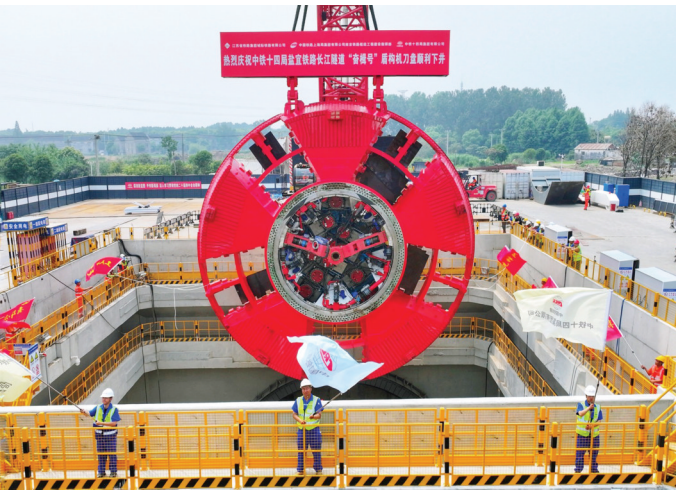
6月4日,“奋楫号”盾构机刀盘吊装下井作业现场 赵亚玲 摄
