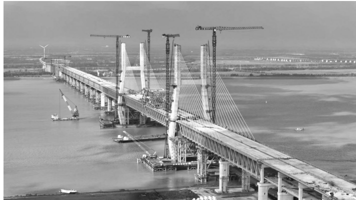
6月9日上午,崇启公铁长江大桥主桥成功合龙
