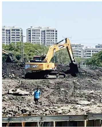
河道清淤施工现场
