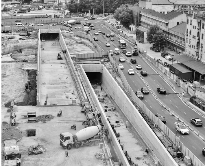
南京鼓楼区惠民大道综合改造工程为建宁西路过江通道江南连接线重要节点,全长2.37公里,主体已完工,正推进机电安装与附属工程,预计三季度主线开通。 范俊彦 摄 视觉江苏网供图
