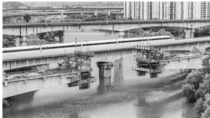
6月24日,建设者在宁芜铁路扩能改造秦淮河特大桥施工现场,抢抓工期稳步推进项目建设。 朱红生 摄 视觉江苏网供图
