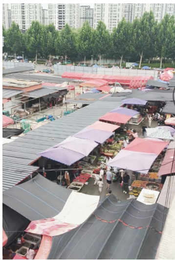
停车场改成商铺后,部分已投入使用,还有的商铺正在修建中
