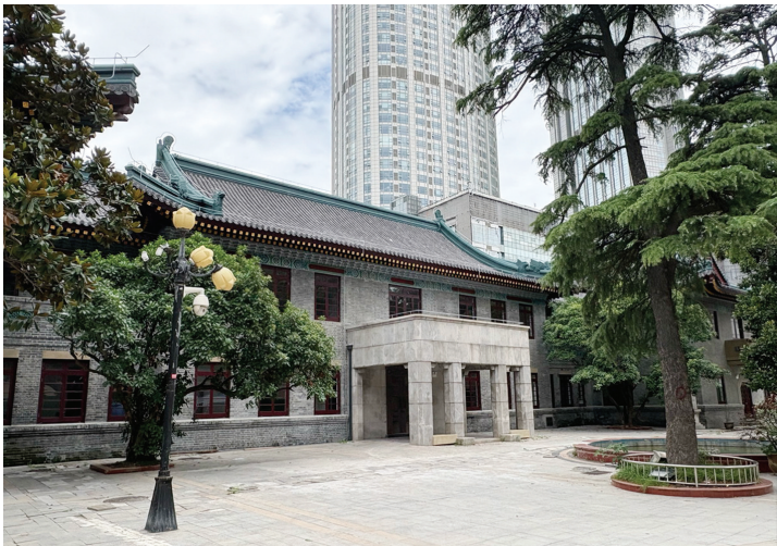
修缮后的原国民政府立法院、监察院旧址
