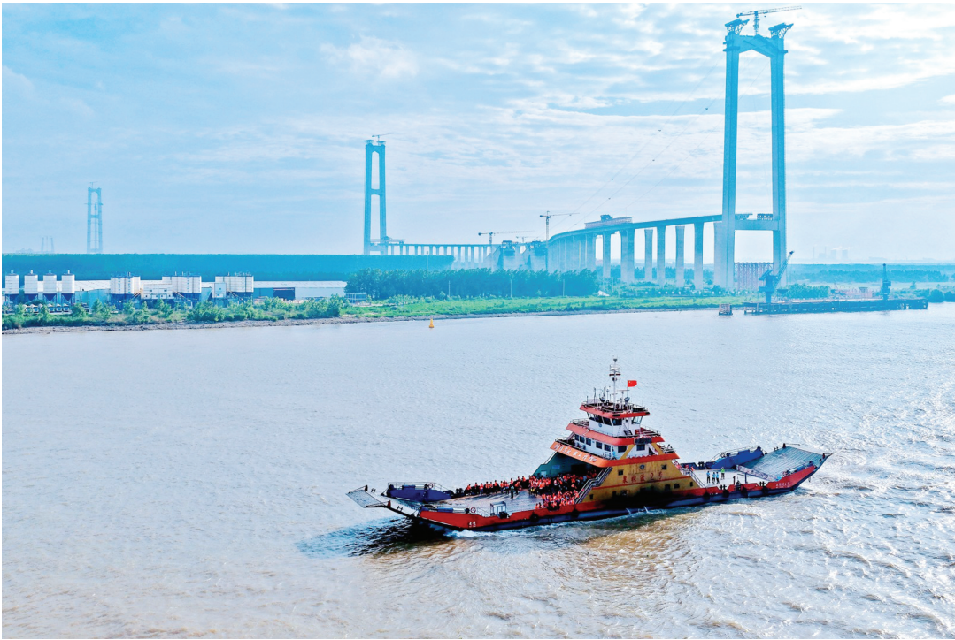
9日下午，张靖皋长江大桥驻民主沙的656名施工人员搭乘轮渡离岛返回岸上。当天，为防御今年9号台风“巴威”，在建中的张靖皋长江大桥驻民主沙参建单位根据防台撤离预案，对所有设施设备进行安全排查并加固，同时组织所有施工人员撤离。 史丹丹 吴树建 摄（视觉江苏网供图）
