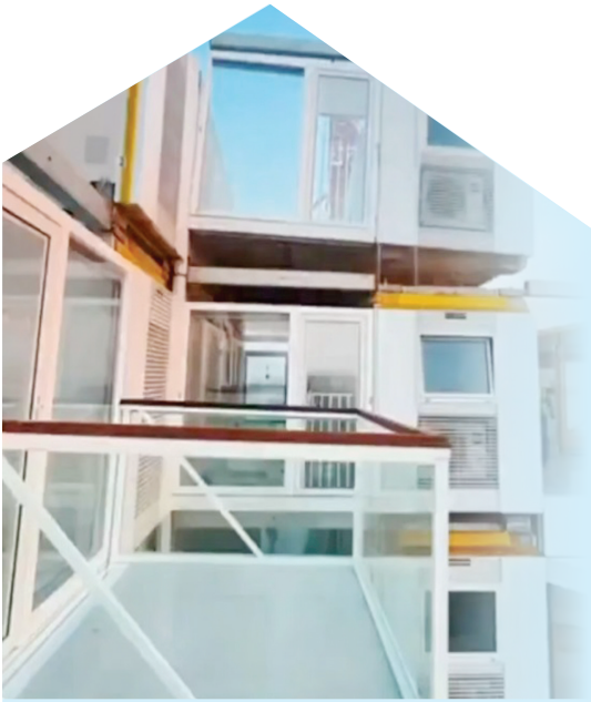
搭建模块化建筑就像搭积木
