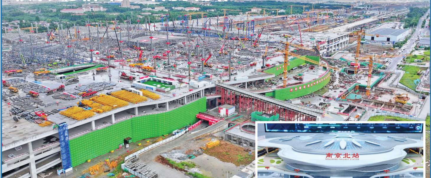
7月20日,南京北站站房施工现场一片繁忙,混凝土主体结构封顶。右图为南京北站设计图 赵亚玲 摄 视觉江苏网供图
